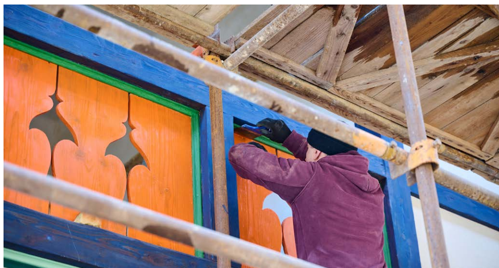
Na budoucí fasádě Vodoléčebného ústavu se pečlivě a intenzivně pracuje
