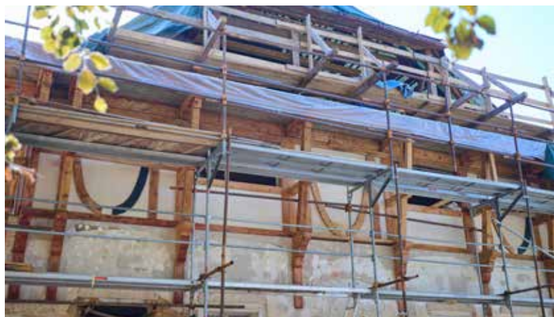
Na fasádě hlavních objektů se začíná rýsovat budoucí barevnost
