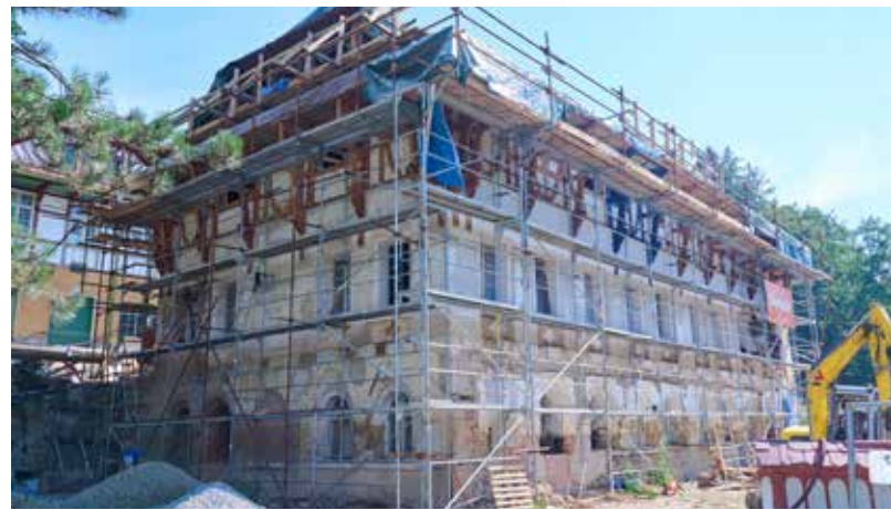
Budova Vodoléčebného ústavu již byla osazena okny
