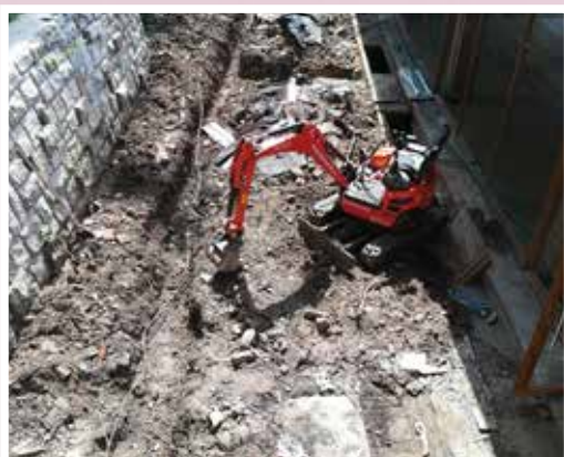
práce v atriu v centrální části kolonády
