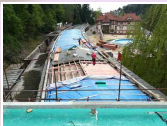
oprava střechy kolonády
