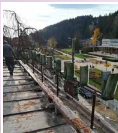
oprava střechy kolonády
