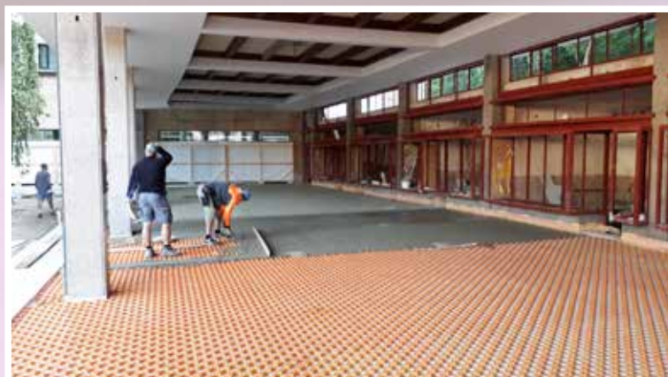
kolonáda během rekonstrukce
